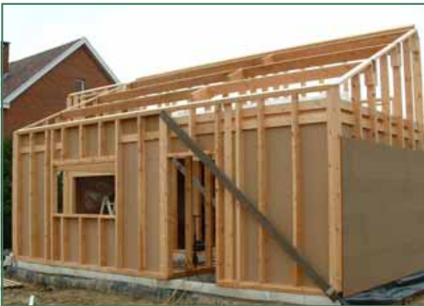
Een houtskeletbouw in uitvoering, architect: Liesbeth Liefsoons. Bron: VIBE
