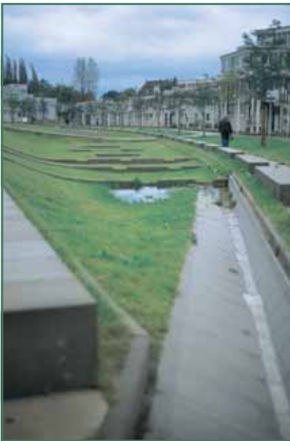
De woonwijk Kupperbusch in Gelsenkirchen (Duitsland), aangelegd op een voormalig mijnterrein. In deze woonwijk werd een infiltratieplas aangelegd, een lensvormige met gras begroeide openbare ruimte. Bron: Erik Rombaut, in Groenbeheer, een verhaal met toekomst, Martin Hermy in samenwerking met afdeling Bos & Groen en VELT.
