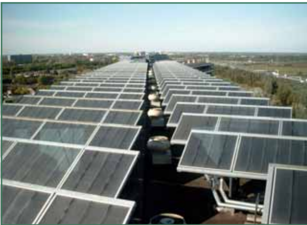
Fotovoltaïsche panelen Bron: Izen
