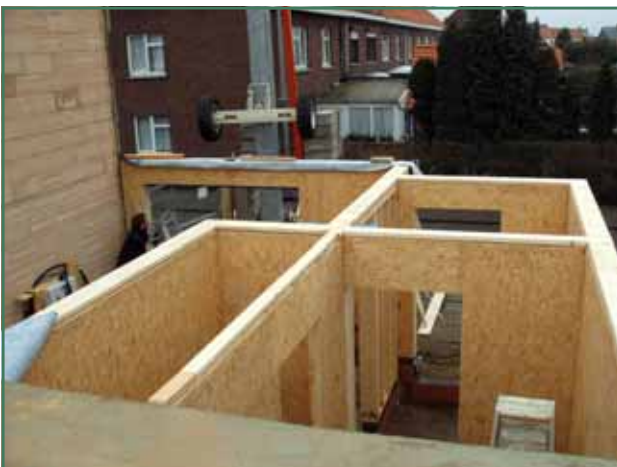
Een houtskeletbouw in uitvoering, architect: Jo Akkermans, aannemer: Hota. Bron: VIBE
