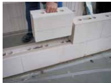
Metselwerk met kalkzandsteen. Bron: Xella, producent van Silka
