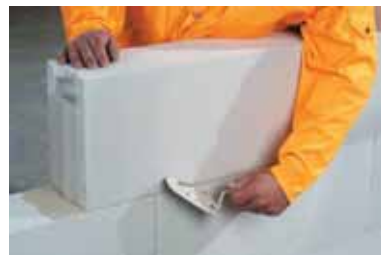
Metselwerk met cellenbetonblokken. Bron: Xella, producent van Ytong
