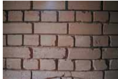
Metselwerk met leemsteen. Bron: VIBE
